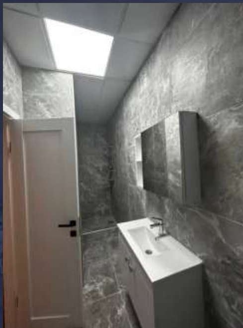
Поточний ремонт санітарного вузла медичного блоку (2024 рік)
