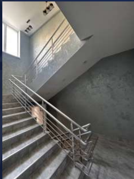
Поточний ремонт сходових клітин № 1 та № 4 (2024 рік)
