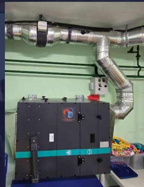
Встановлення системи примусово-витяжної вентиляції (2024 рік)
