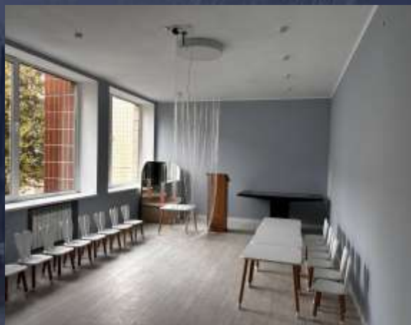
Поточний ремонт сенсорної кімнати (2024 рік)
