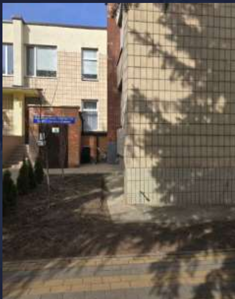
Встановлення системи пасивного блискавкозахисту (2024 рік)
