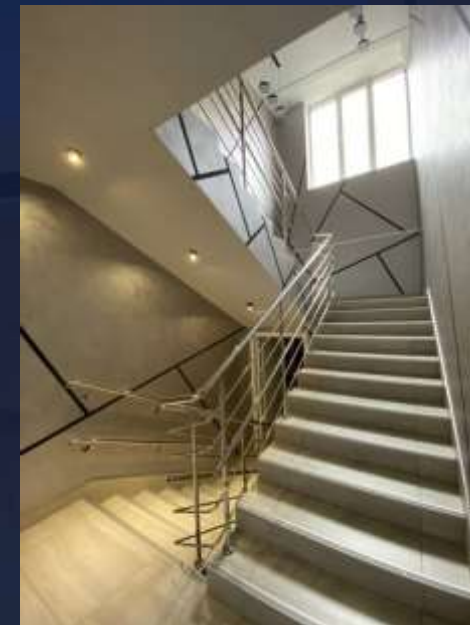
Поточний ремонт сходових клітин № 2 та № 3 (2024 рік)
