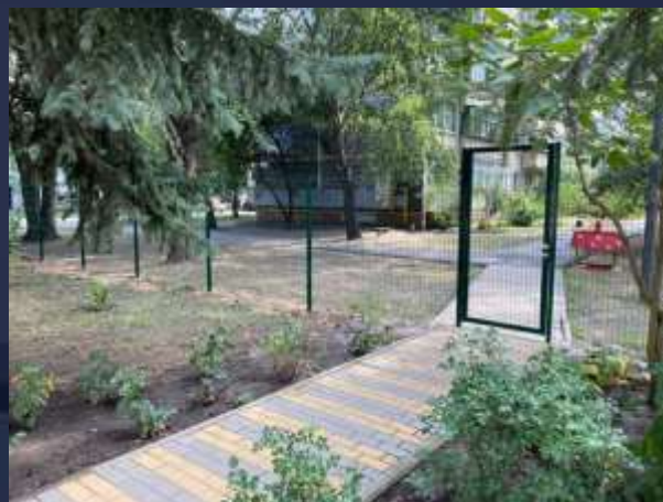
Поточний ремонт паркану (2024 рік)
