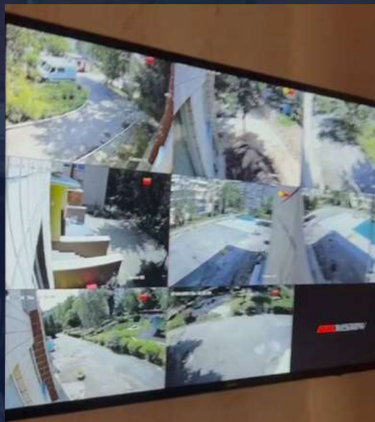
Встановлення системи зовнішнього відеоспостереження (2024 рік)
