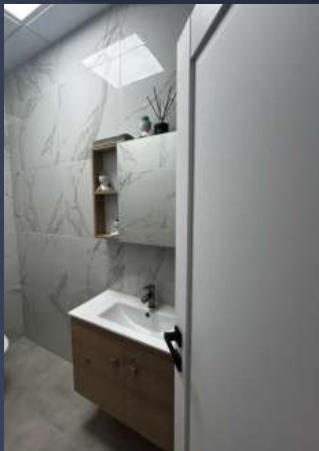
Поточний ремонт санітарного вузла загального користування (2024 рік)
