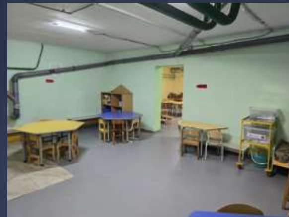
Поточний ремонт укриття (2024 рік)
